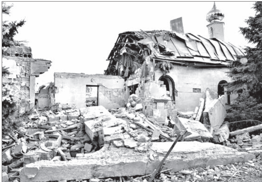
Разрушенный храм святого праведного Иоанна Кронштадтского в г. Кировское
